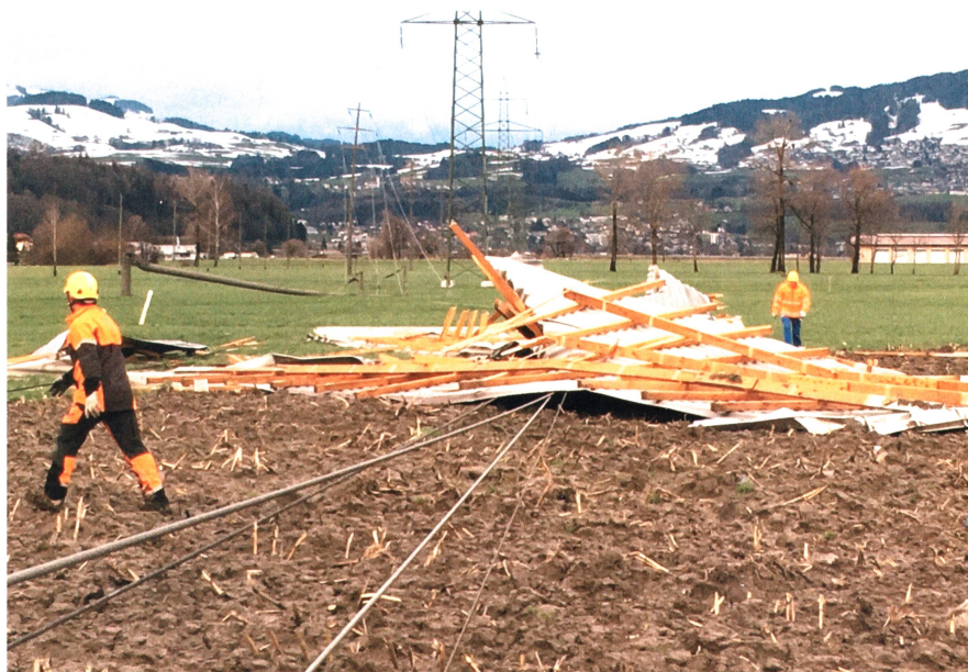
Bild 1 Ausfall einer 50-kV-Leitung in Tuggen infolge des Sturms Burglind am 3. Januar 2018.
