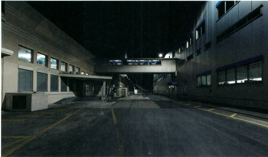
Der Durchgangsbereich bei Emmi ist gut ausgeleuchtet, sodass sich Fussgänger und Lastwagenfahrer sicher fühlen.
