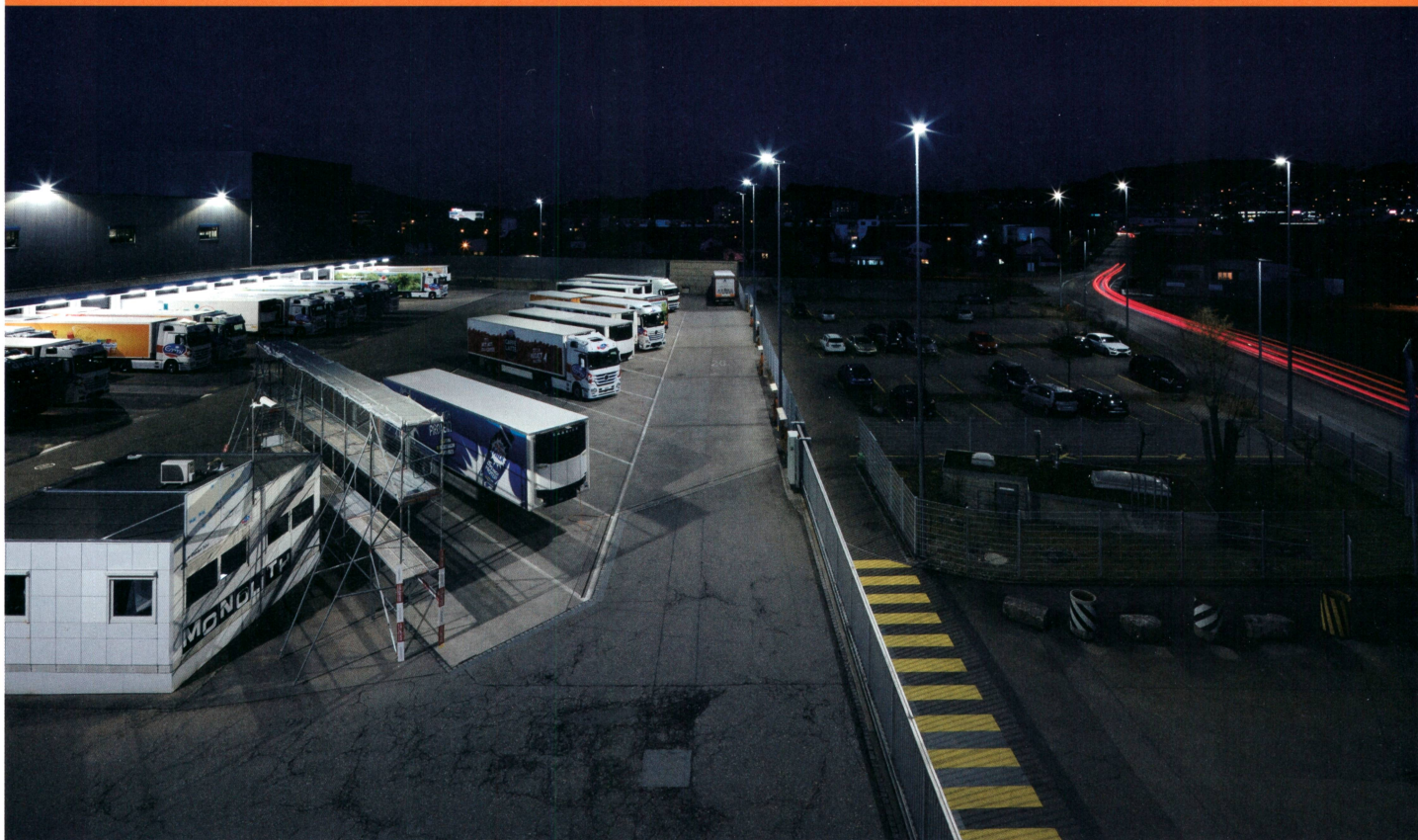
Der Verladebereich des Logistikcenters von Emmi in Suhr (links) und der Mitarbeiterparkplatz (rechts) im neuen Licht.
