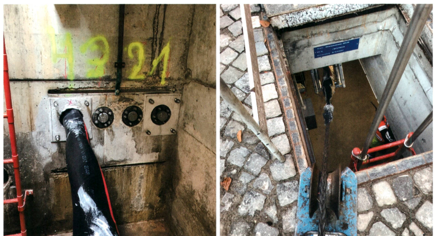
Bild 1 Eingezogenes 150-kV-Dreileiterkabel in bestehendem Kabelschutzrohr durch Muffenschacht.
