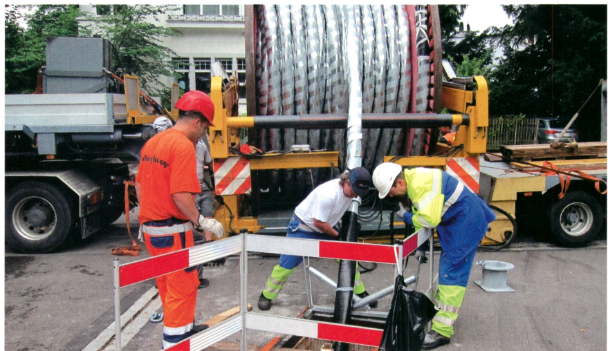
Bild 4 Kabeleinzug des ersten 150-kV-Dreileiterkabels im Jahr 2014.
