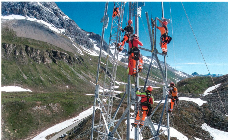
Montage der Masten am Albulapass.
