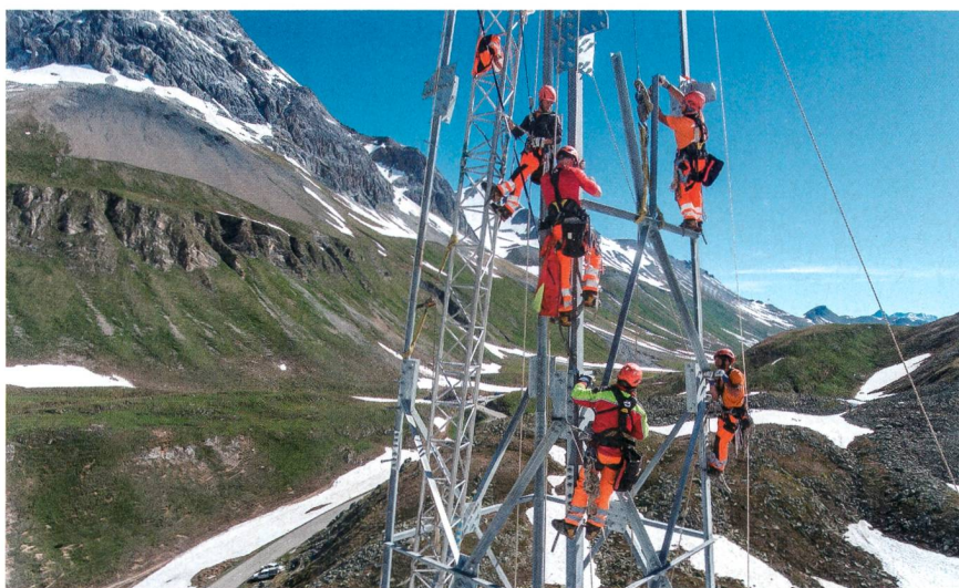
Montage der Masten am Albulapass.
