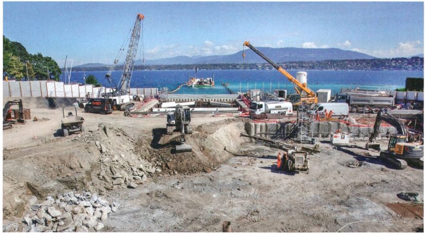
Travaux de construction de la nouvelle station de pompage au Vengeron.
