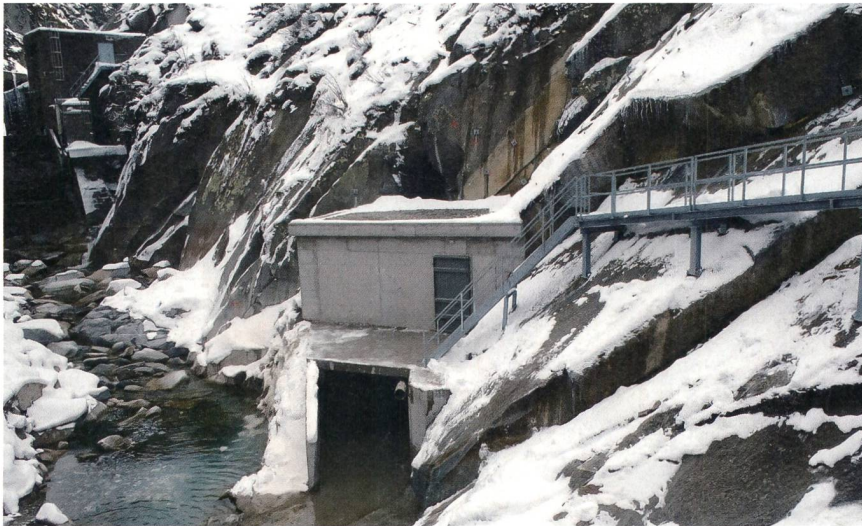
Das Kraftwerk unterhalb von Andermatt verwertet Restwasser.
