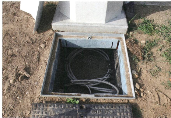
Ordnung im Schacht ermöglicht sauberes Arbeiten.
