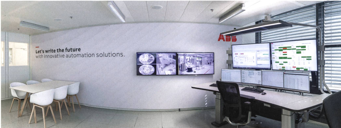
Dans la salle de contrôle, les informations nécessaires pour le pilotage de la production ainsi que les images en live stream sont affichées dans l'IHM (interface homme-machine). Ainsi, une seule personne suffit pour diriger l'ensemble de la production.
