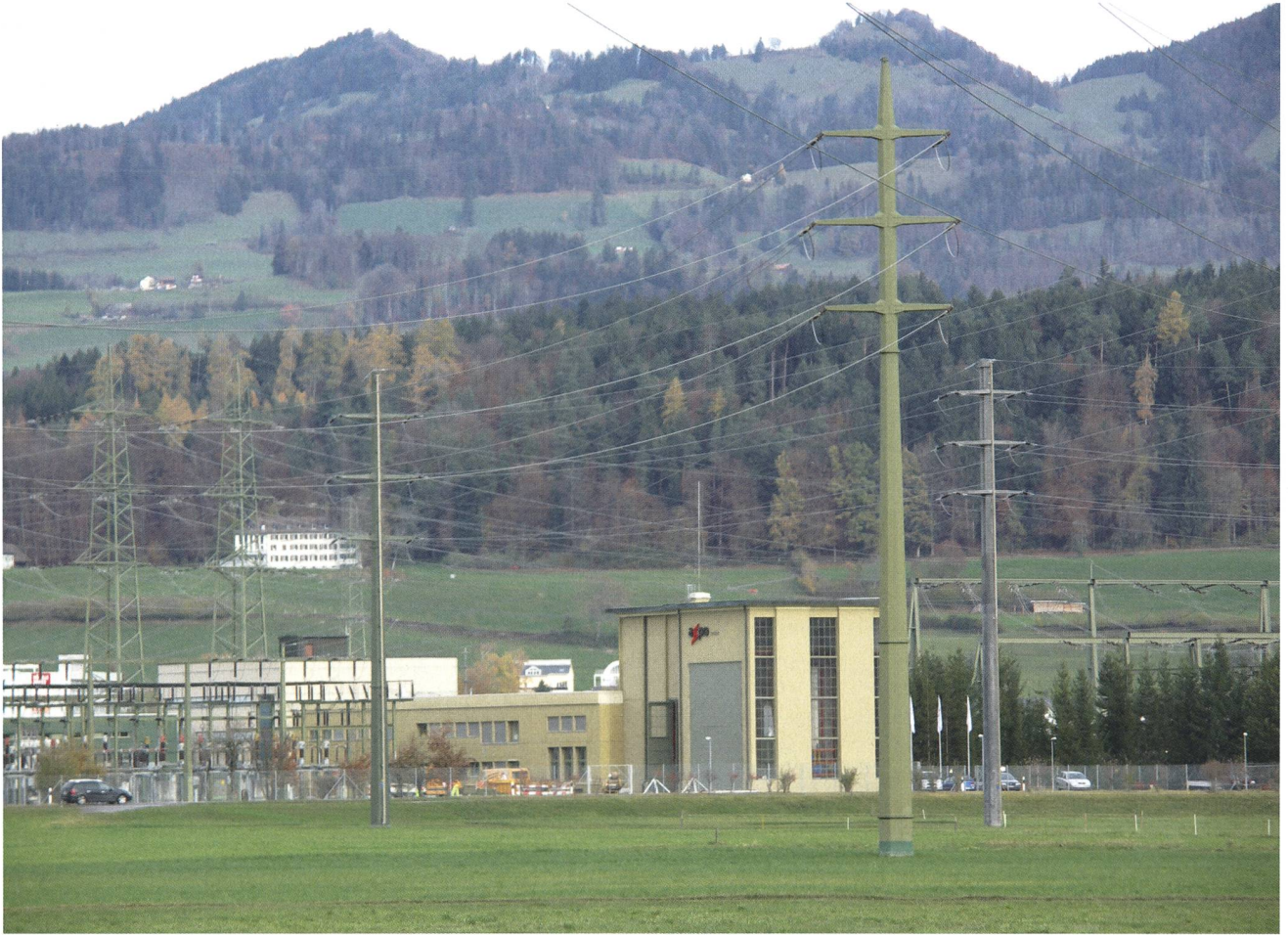
Das Unterwerk Grynau.
