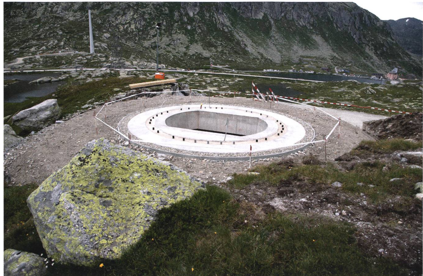
Im Fundament einer Windanlage sind 700 t Beton verbaut.
