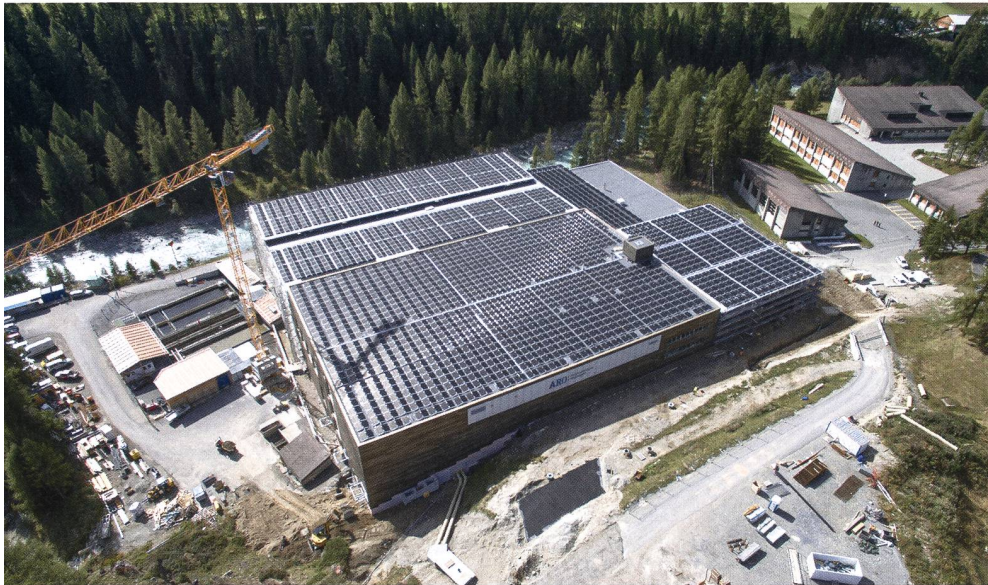
3447 Solarmodule befinden sich auf dem Dach der ARA Oberengadin in S-chanf.
