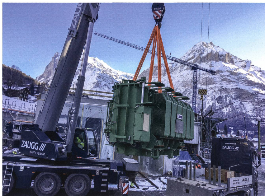
Bild 3 Anlieferung eines 25-MVA-Transformators in Grindelwald.
