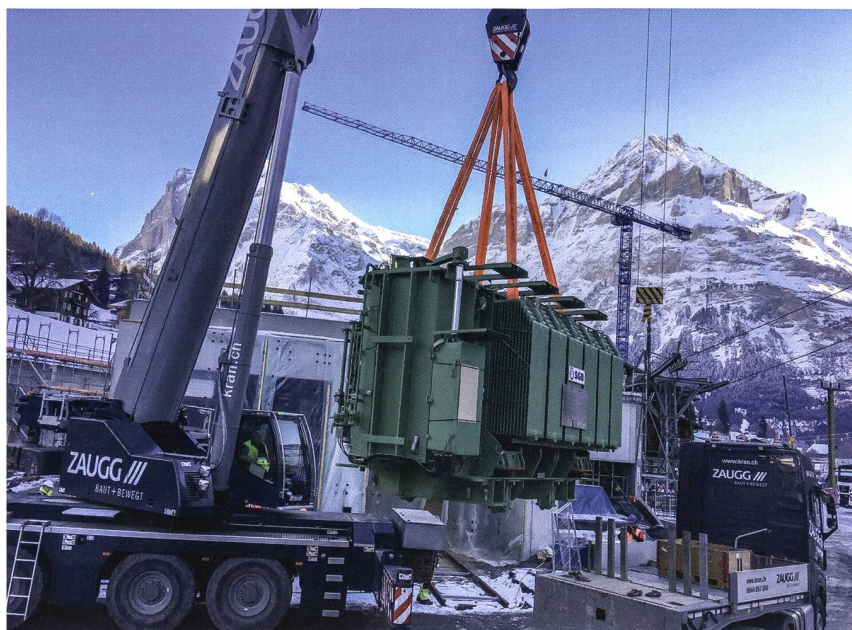
Bild 3 Anlieferung eines 25-MVA-Transformators in Grindelwald.
