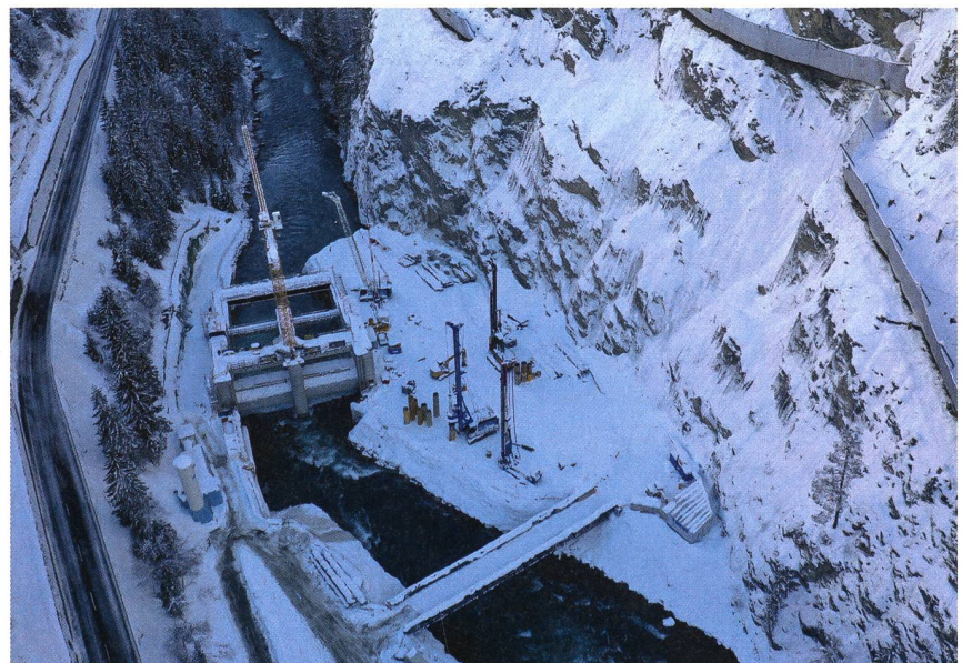
Bild 2 Der Betrieb der Wehrbaustelle muss bei schneereichen Wintermonaten eingestellt werden, weil die mit Schnee verfüllten Steinschlagschutznetze die Sicherheit auf der Baustelle nicht mehr garantieren können.
