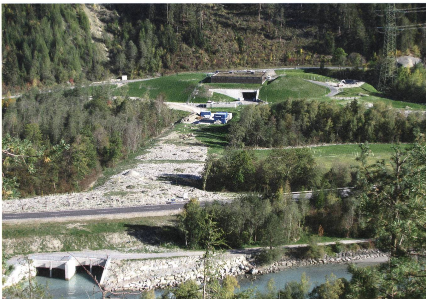
Bild 4 Die Zentrale in Prutz ist bereit für die Betriebsaufnahme.
