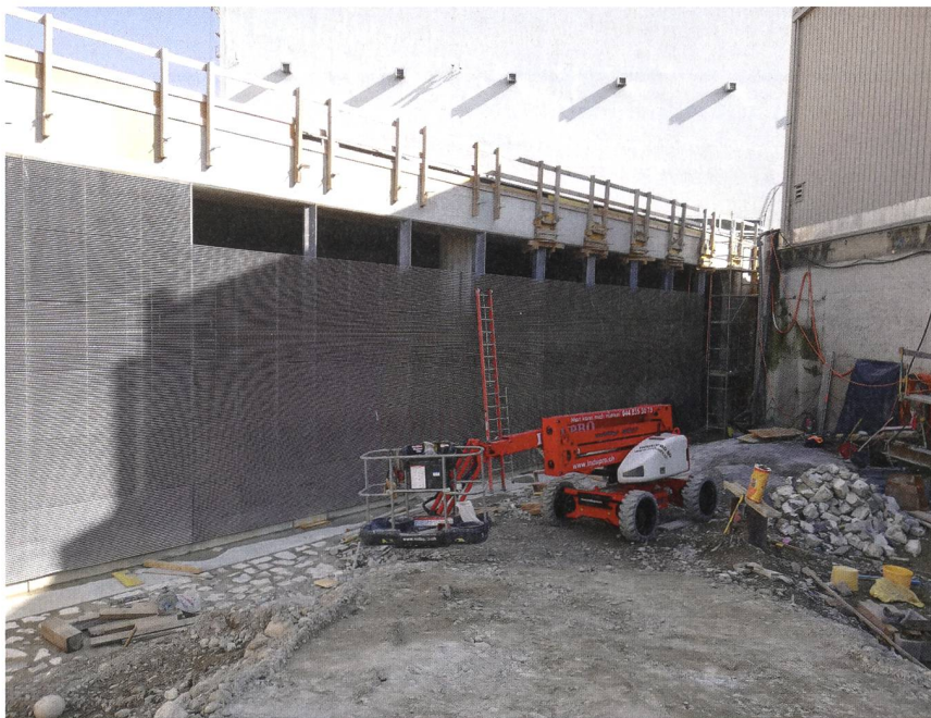
Bild 6 Das Limmat-Kraftwerk in Dietikon verfügt seit 2019 über den grössten Horizontalrechen in der Schweiz mit einer Rechenfläche von über 200 m 2 und einem Stababstand von 20 mm. Der Bypassseingang befindet sich rechts beim Baurüst.
