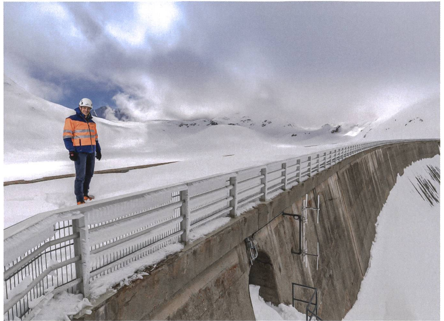
Die Staumauer Gries in Oberwallis.
