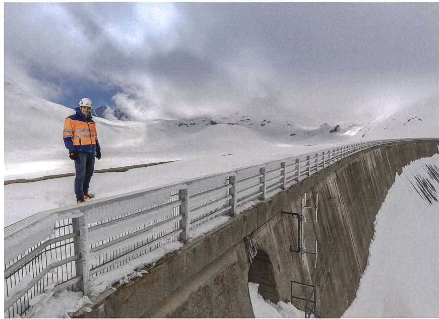
Le barrage de Gries dans le Haut-Valais.
