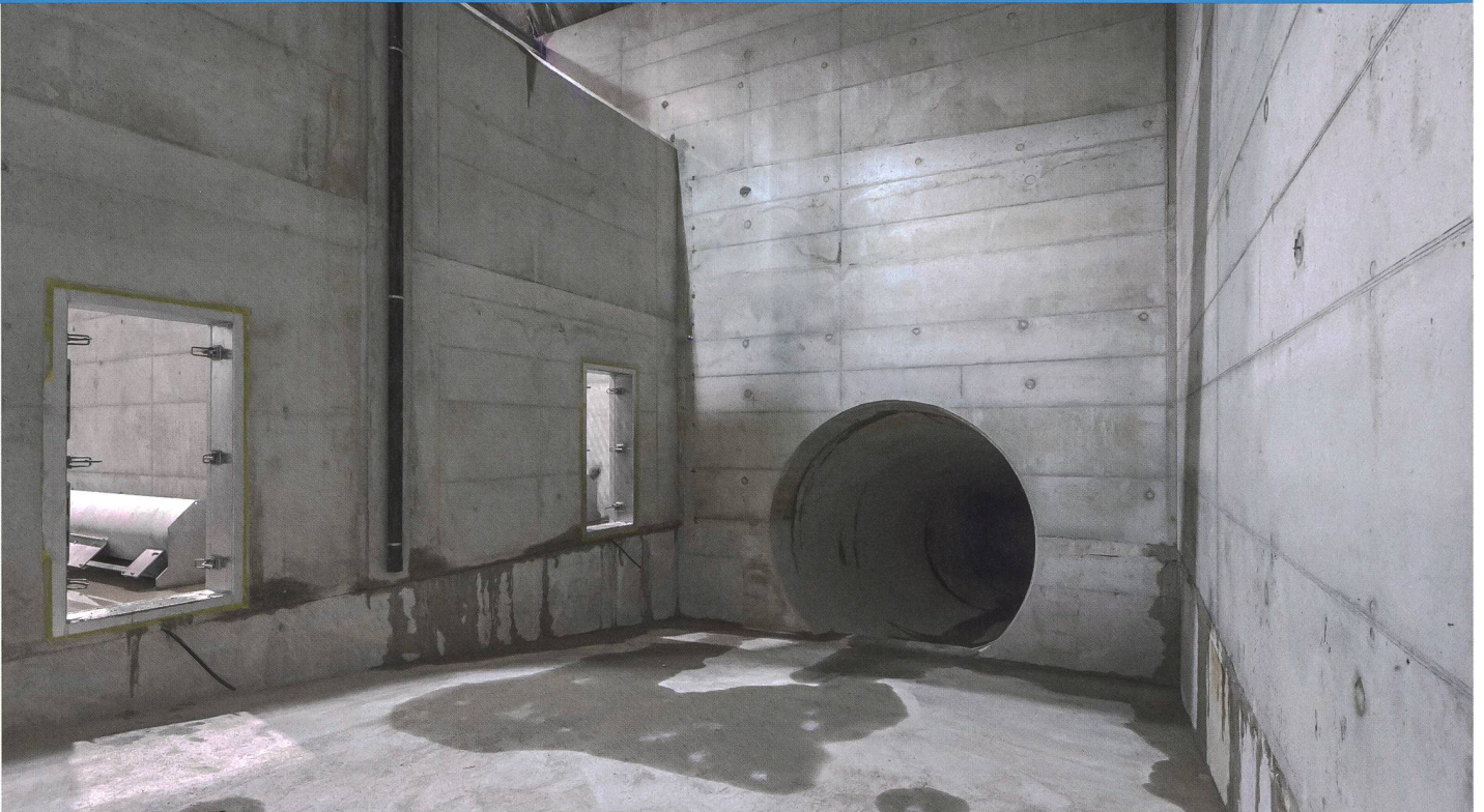
Druckaufbaukammer während des Baus.
