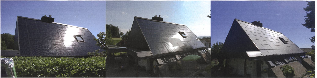
Bild 4 Das Norddach des betroffenen Einfamilienhauses vor der Blendsanierung (links), bei der Bemusterung (Mitte) und mit den neuen satinierten PV-Modulen (rechts).
