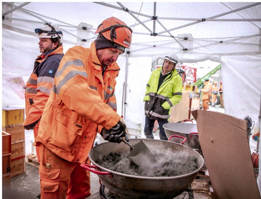
Non, on n'est pas à la cantine. Ici, on réalise des tests sur le béton frais.
