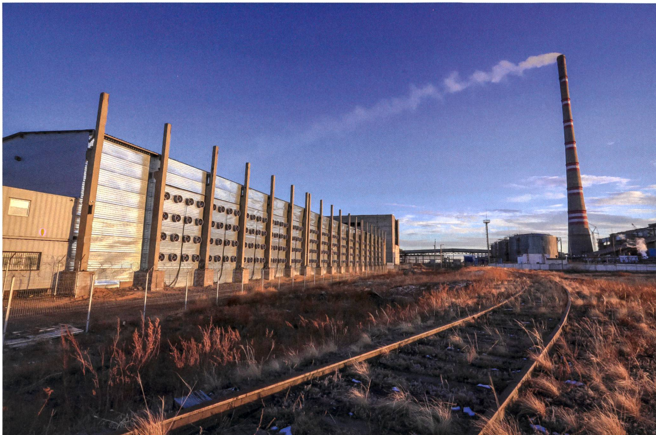
Kryptowährungs-Rechenzentrum neben einem Kohlekraftwerk in Kasachstan.
