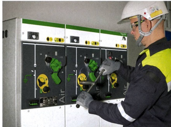
Le nouveau tableau de distribution moyenne tension sans SF 6 en version 12 ou 24 kV pour postes de boucles réseaux.
