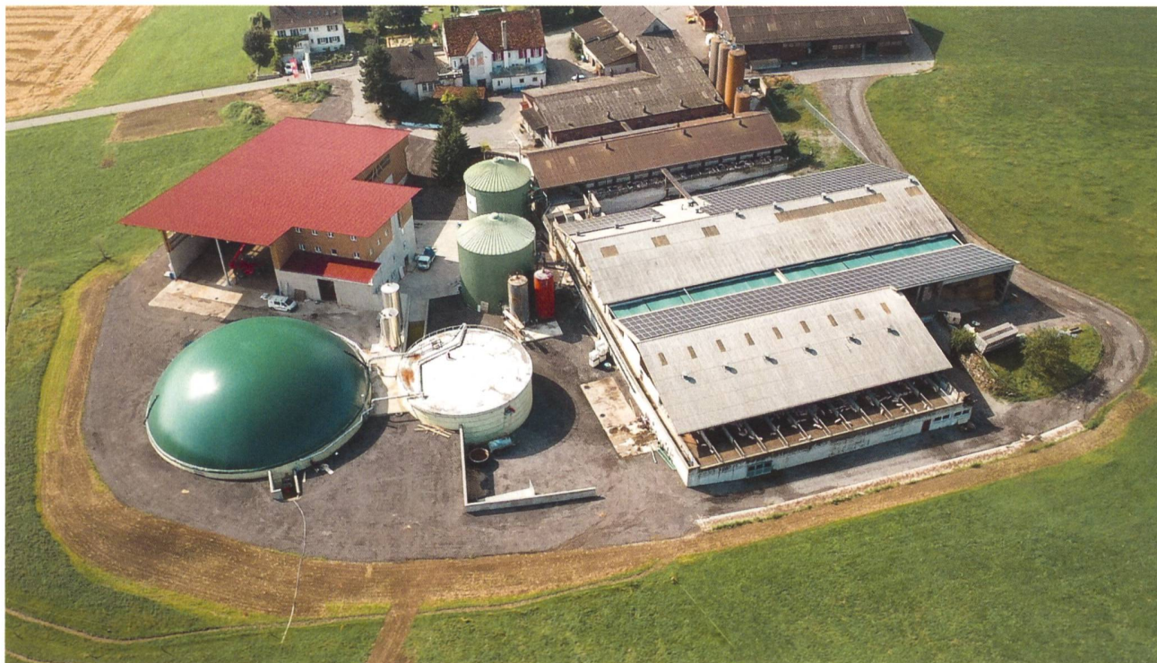
L'exploitation agricole « Holzhof » où ont été réalisés les essais en conditions réelles.
