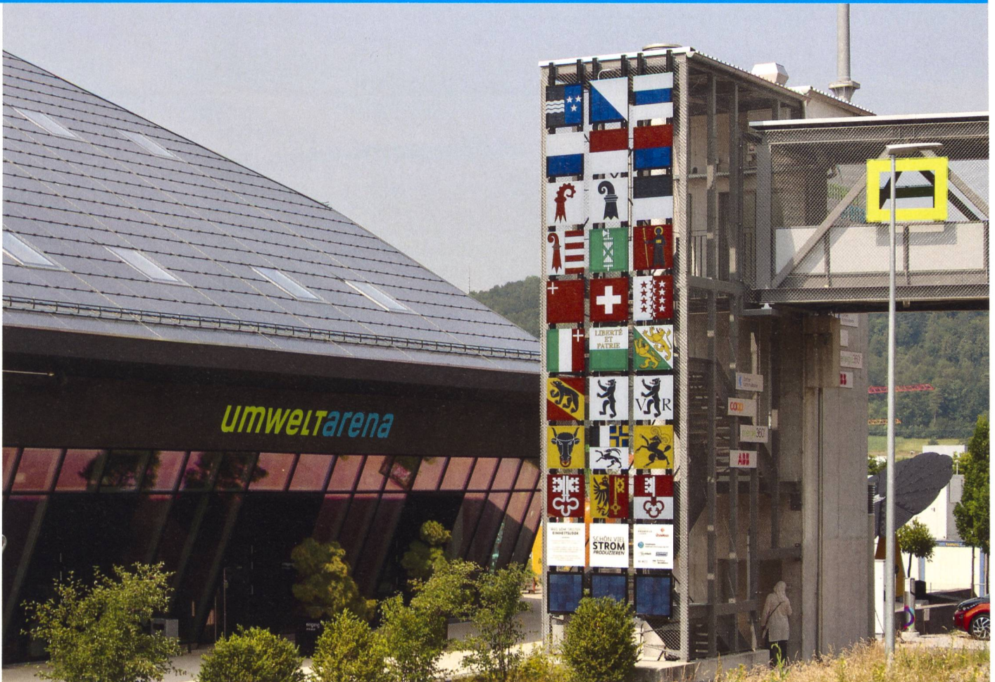
Als Kantonswappen gestaltete PV-Module.
