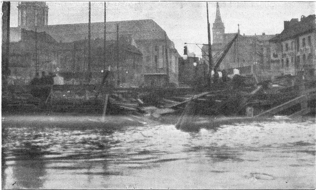
Ueberschwemmung der Berliner Untergrundbahn durch Dambruch der Spree. Unser Bild zeigt die Stelle, an welcher der Dambruch eintrat. Von hier aus wälzten sich die Wasser der Spree in die Untergrundbahnschächte.
