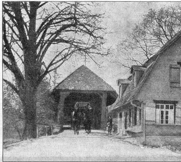
Der Durchpaß der alten Thurgaubrücke bei Weinfelden mit der Post und dem alten Zollhaus.
