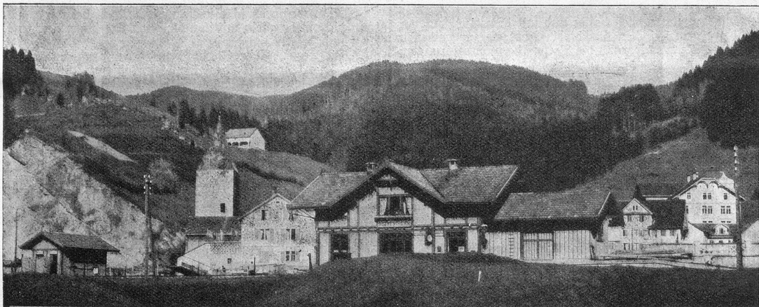
Dorf und Bahnhof Rothenthurm (Kant. Schwyz), an der Bahnlinie Wädenswil über den Sattel nach Arth-Goldau, direkt an der neu entdeckten Lehimauer liegend, allwo die Schwyzer unter Roding am 2. Mai 1798 heldenmütig die Franzosen schlugen, welche 2000 Mann auf dem Kampfplatz ließen.
