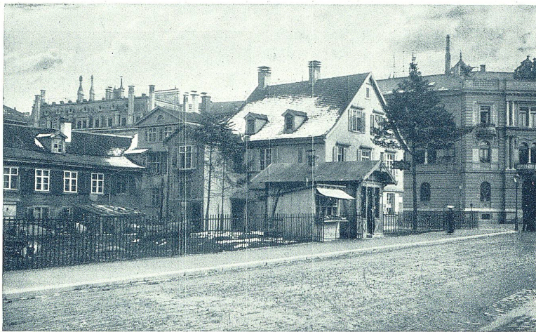
Zum Abbruch bestimmte Häuser an der Kornhausstrasse.
