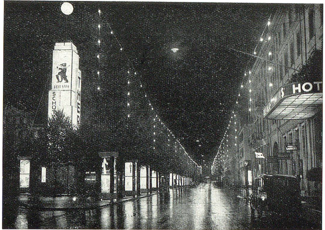
Blick in die Poststraße
