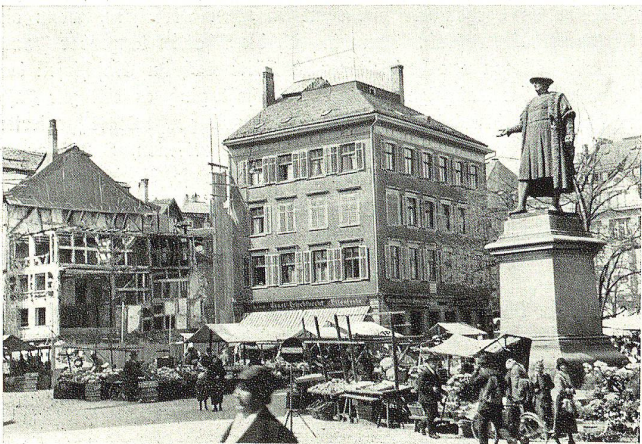
Die Stadtschreiberei vor dem Abbruch.
