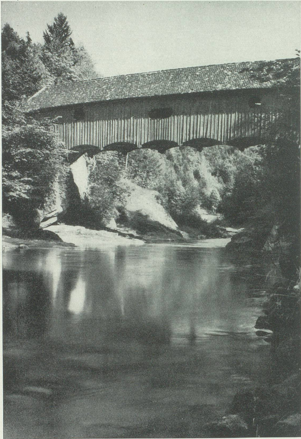
Brücke über die Sitter bei Zweibrücken
