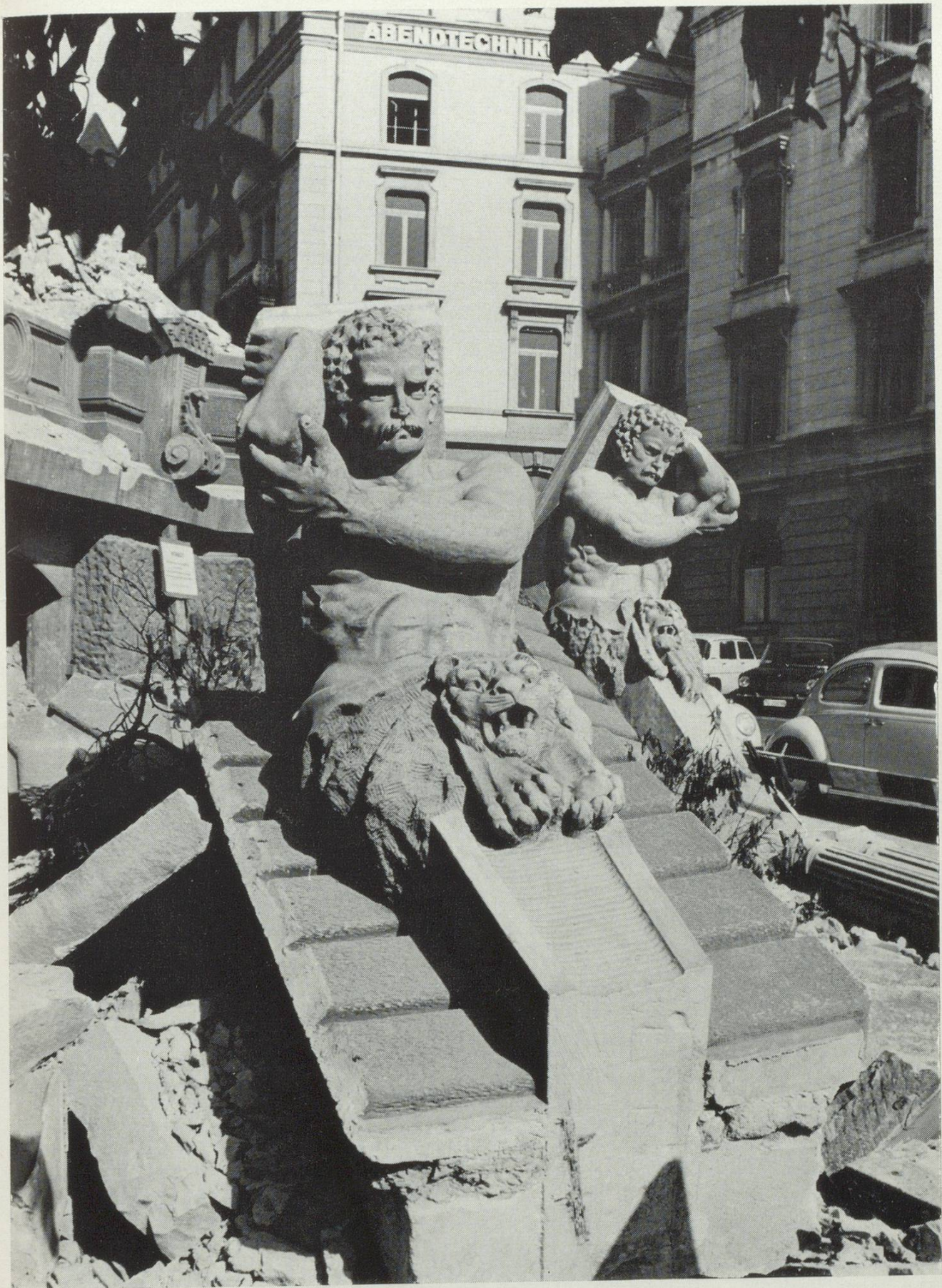
Aufrecht noch im Fall. Einiges zu diskutieren gab der Abbruch der Häuser an der Rosenbergstraße 26-28
