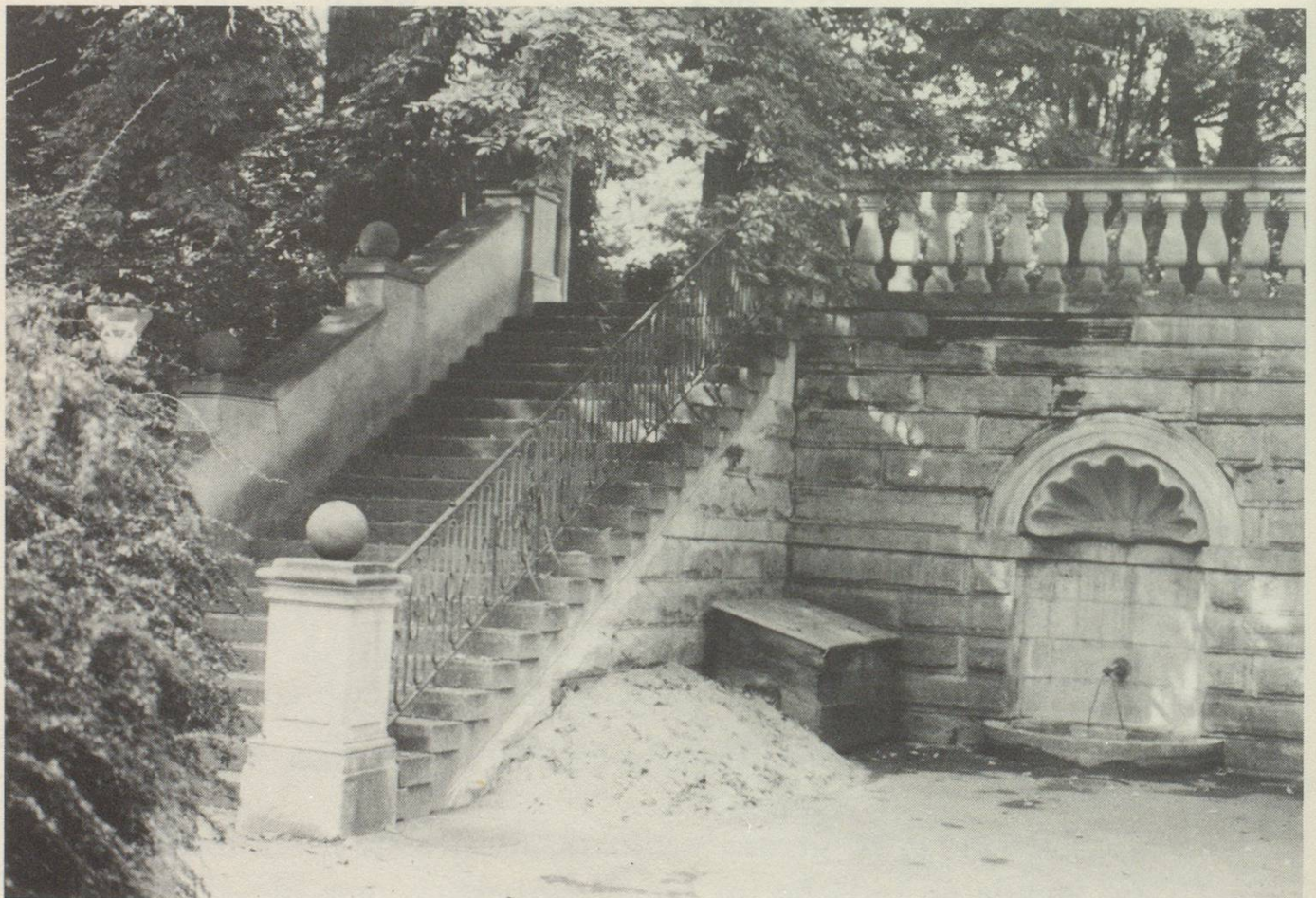
Diese schöne Treppenanlage mit der «Muschelnische» am Badehäuschen wird heute als Streugutlager genutzt.
