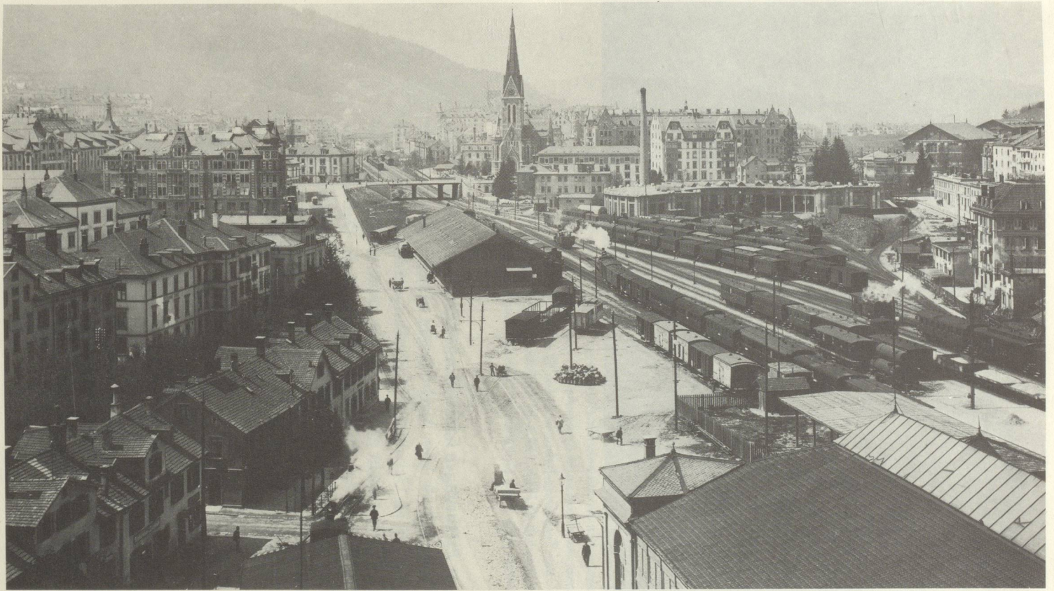
Das westliche Bahnareal zwischen 1906 und 1910: Man sieht deutlich die noch junge Aufdümmung der westlichen St. Leonhard-Strasse und ihre Abwinklung in die Achse der Poststrasse. Im Vordergrund das «Zoll- und Niederlagsgebäude», abgebrochen für den Neubau des Aufnahmegebäudes. An der Stelle der niederen Häuser rechts steht heute die Hauptpost. Der Strassenraum selbst ist noch kaum gegliedert: Fussgänger, Fuhrwerke und Bahn im friedlichen Nebeneinander. (Foto städtisches Bauarchiv)
