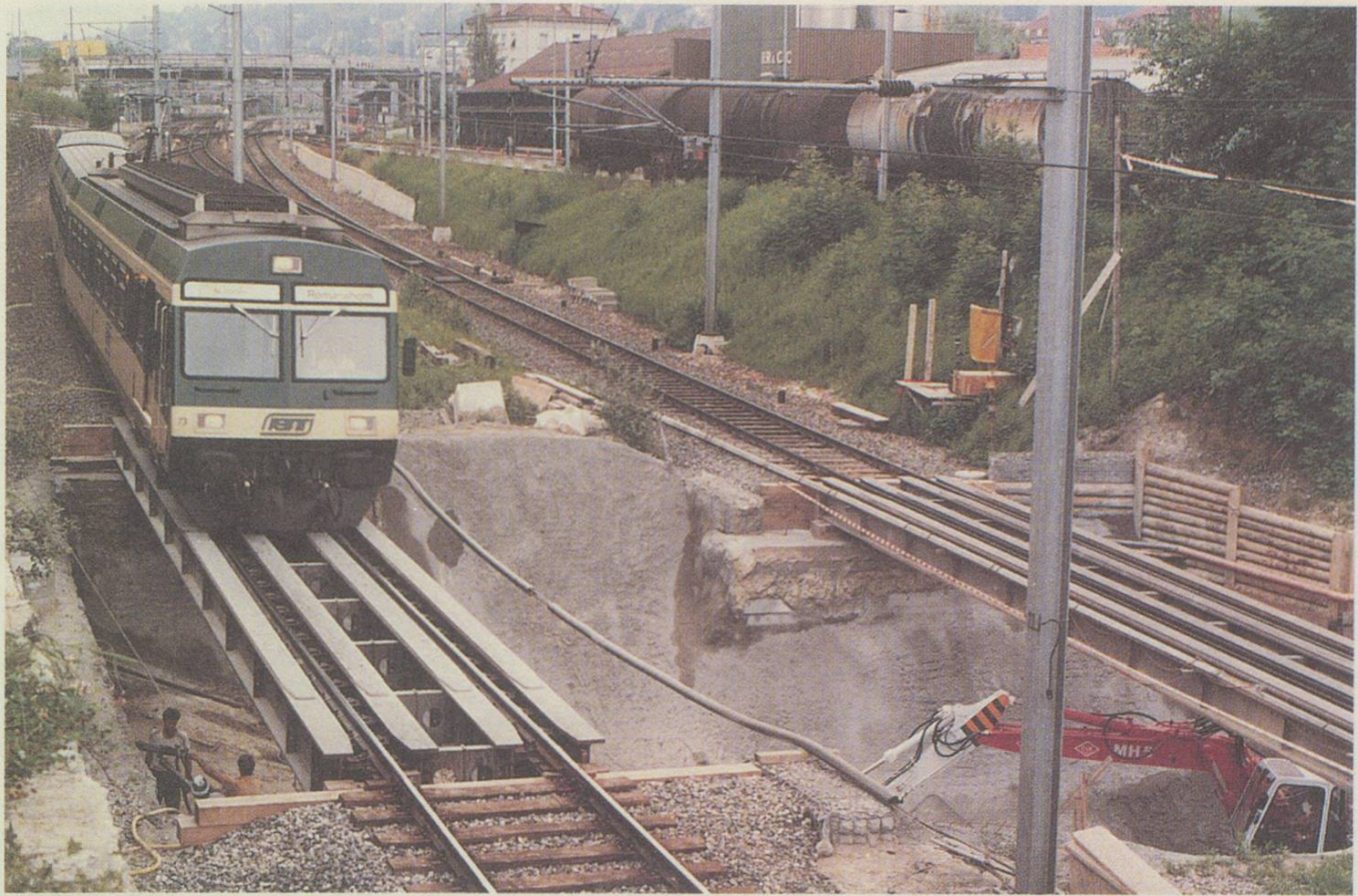
Hilfsbrücken für die beiden Bahnlinien: Die Widerlager der Brücke mussten auf 4–5 Meter tiefe Bohrpfähle abgestellt werden. Pro Nacht musste nach Bauprogramm ein Pfahl gebohrt und betoniert werden.
