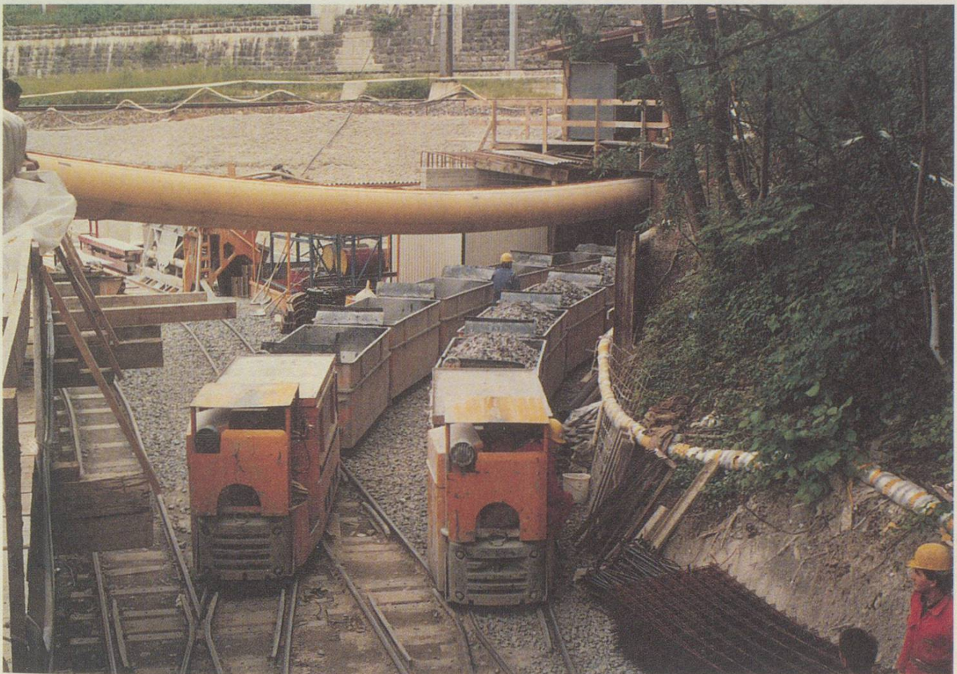
Ausfahrt der Stollenbahn mit dem Felsmaterial.
