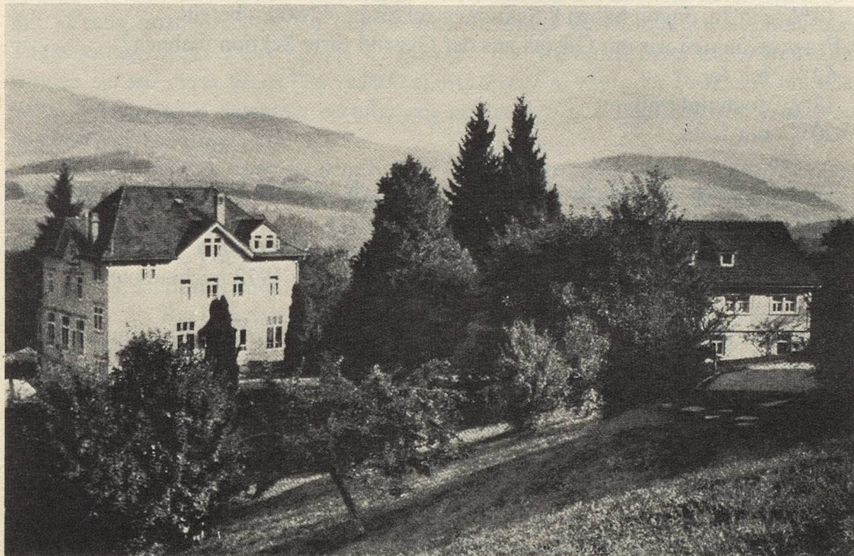
Das Ferienheim für Mutter und Kind in Waldstatt AR. Links das renovationsbedürftige Hauptgebäude, rechts das Kinderhaus
