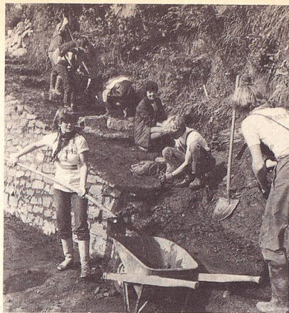
Alle Arbeiten werden sehr sorgfältig ausgeführt. Die Werke müssen zweckmässig und dauerhaft sein
