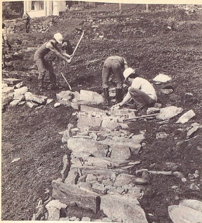
Lehrlinge einer Firma aus der deutschen Schweiz im Freiwilligeneinsatz beim Treppenbau
