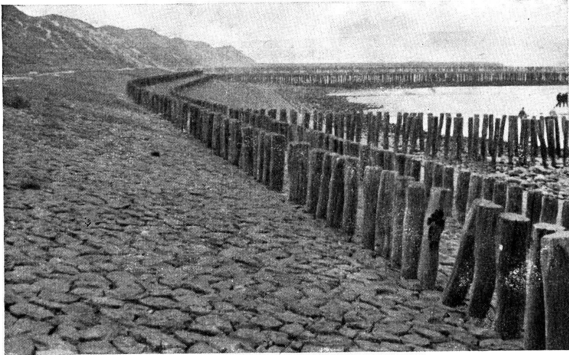
Bild 1: Westkapelle auf Walcheren. Vorwerk der Dünen und des Deiches. Basalt-Panzerung, Bunnen.
