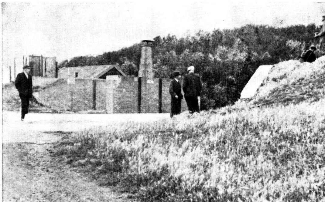
Bild 4: Westland. Deich (Schlafdeich) mit Strassendurchlass bei s'Gravezande.
