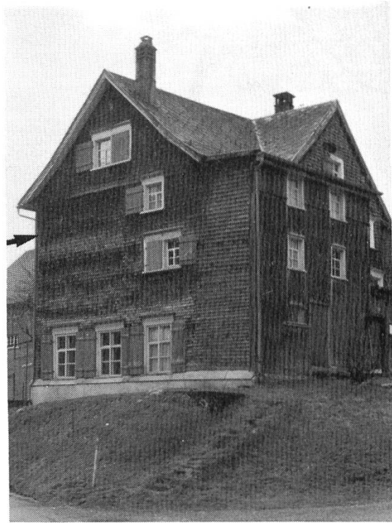
Bild 4: Spaltquartier der Kleinen Bartfledermaus hinter dem Schindelschirm eines alten Wohnhauses.
