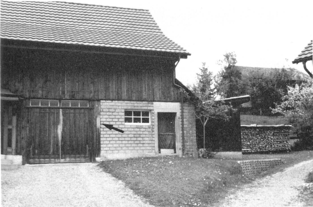
Bild 9: Wochenstubenquartier der Zwergfledermaus in der Fassade einer Scheune.
