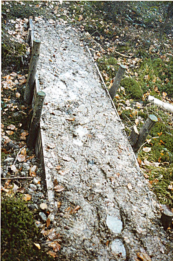
Abbildung 7: Neu errichteter Staudamm im Abflussgraben.
