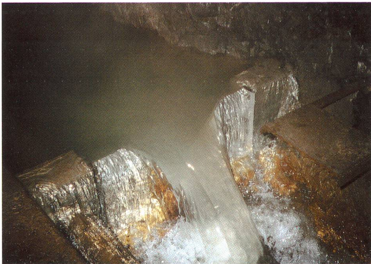
Abbildung 4: Wassermessstelle mit Dreiecksüberfall am Eingang des Basisstollens bei extrem hohem Wasserstand (ca. 4000 l/min), wo sogar die Stollengleise überspült wurden.
