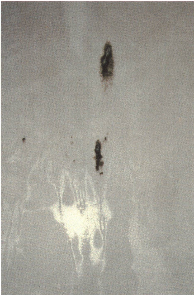
Abbildung 9: Trinkwasserspeicher mit Bewuchs.
