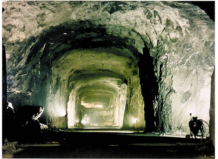
Abbildung 8: Im Untertagesteinbruch Schollberg entstehen durch den Kalkabbau 18 Meter hohe Kavernen. Foto Steinbruch Schollberg.
