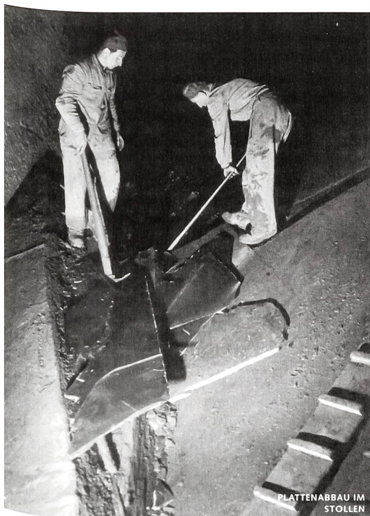
Abbildung 33: Plattenabbau im Stollen. Foto Stiftung Landesplattenberg.
