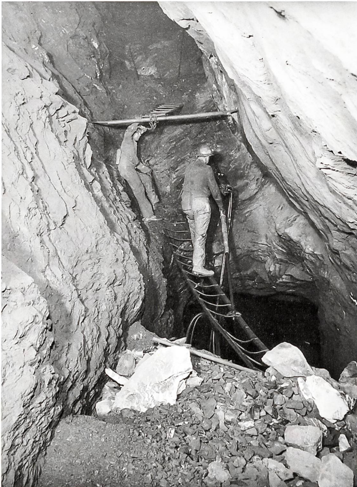
Abbildung 21: Gesteinsabbau im Steillager des Eisenbergwerks Gonzen. Foto Historischer Verein Sarganserland.
