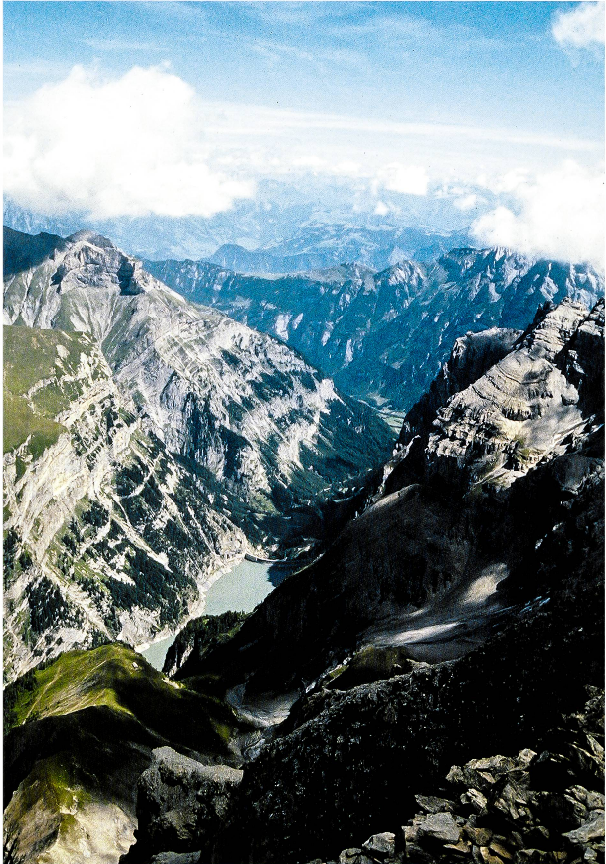
Abbildung 7: Der Stausee Gigerwald im Calfeisental. Foto D. Imper.
