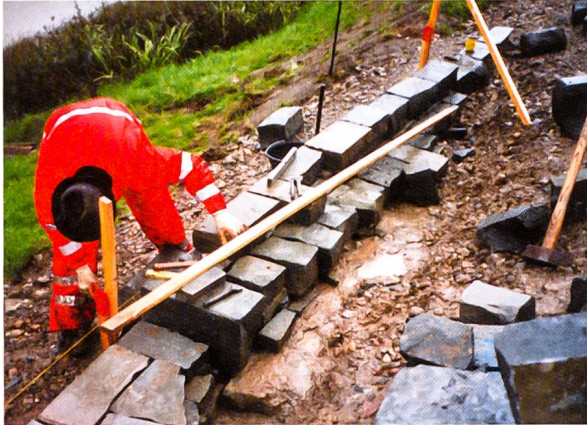
Abbildung 2: Handwerkskunst beim Mauerbau.
