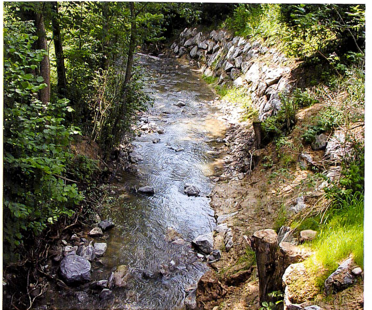
Abbildung 13: Naturnahe Bachverbauungen im Quartier St.Georgen tragen zu einer Erhöhung der Artenvielfalt bei. Foto Toni Bürjin.
