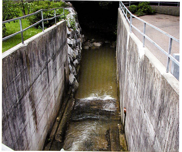
Abbildung 12: Der Einfluss des Rütibachs erfolgt über eine betonierte Rampe. Hier zeigt die Natur nur wenig Vielfalt. Foto Toni Bürgin.
