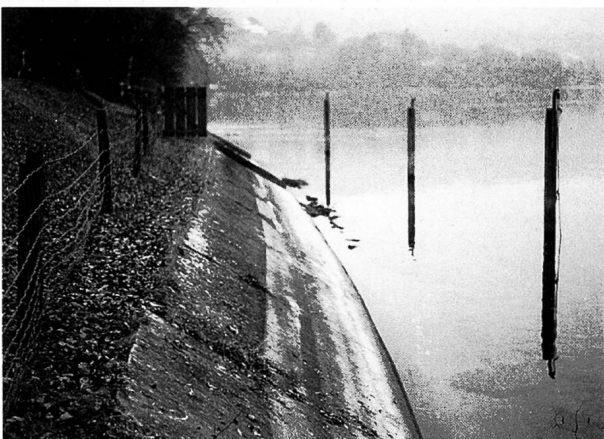
Abb. 2. Massive Betonplatte als Erosionsschutz.
