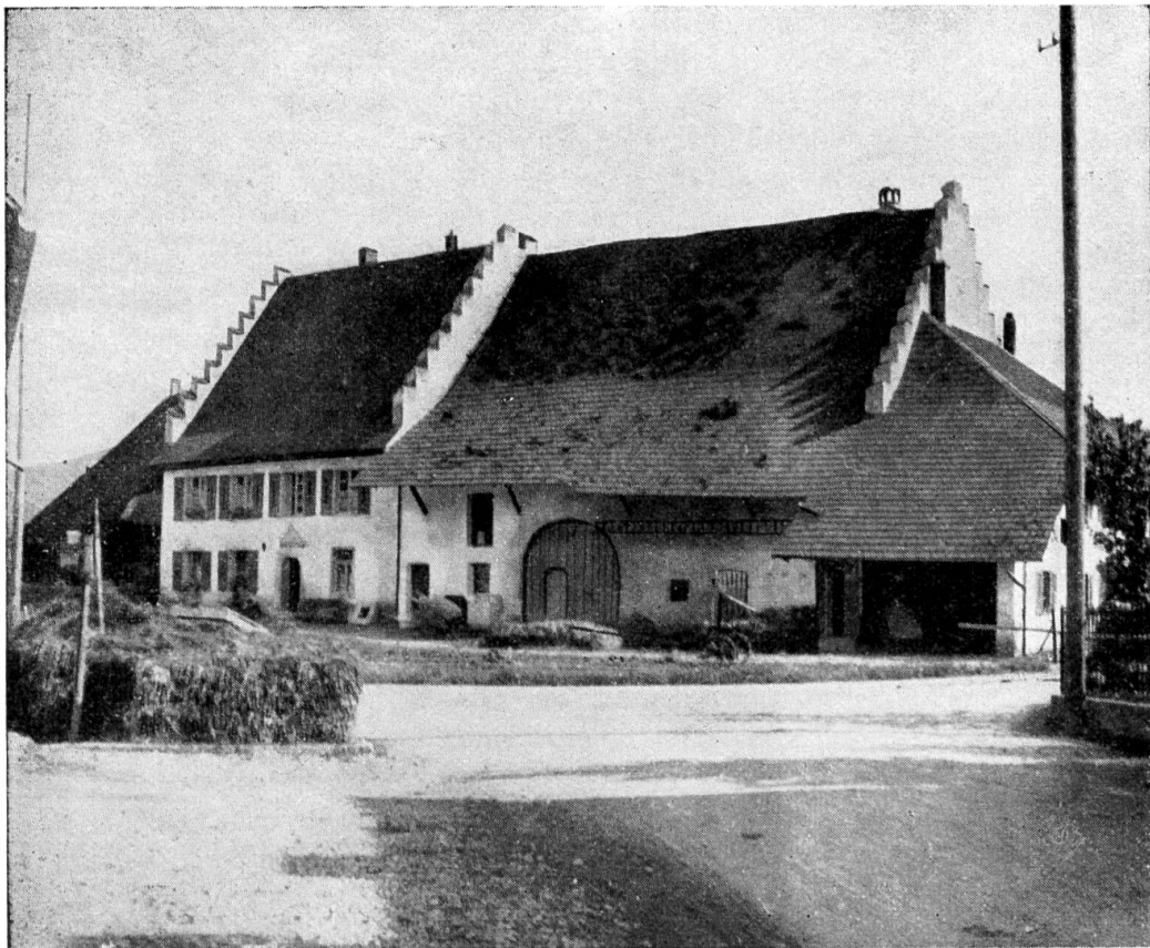
Figur 3. Altes Steinhaus mit Treppengiebel.
