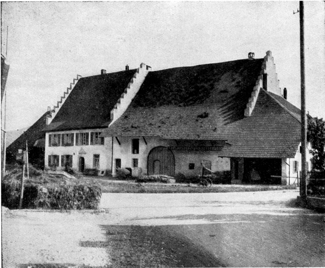
Figur 3. Altes Steinhaus mit Treppengiebel.
