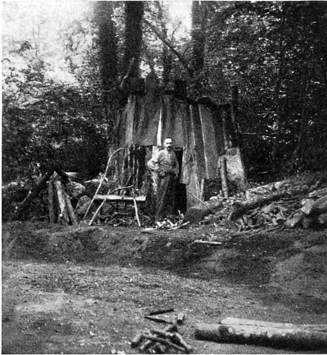
La cahute ou bacu du charbonnier.
