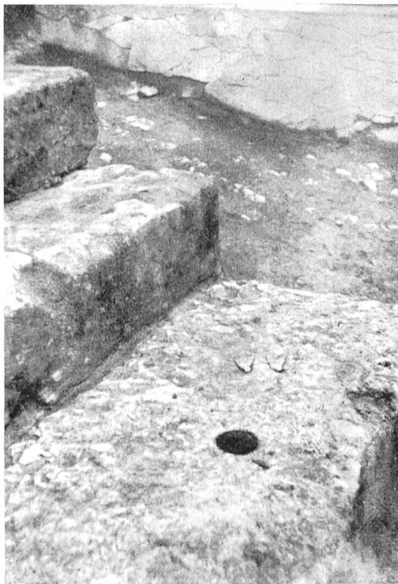
Sohlstein des ehemaligen Galgens von Wegenstetten, jetzt Treppenstufe beim Hause No. 23.
