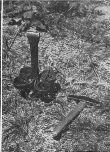
Abb. 3: Monte Refontana, Gemeinde Braggio (Val Calanca) Dengeleisen mit schneckenförmig ge- bogenen Bändern, das zum Dengeln auf der Erde dient. Daneben liegt der kurzstielige Hammer mit der breiten Schlagfläche.
