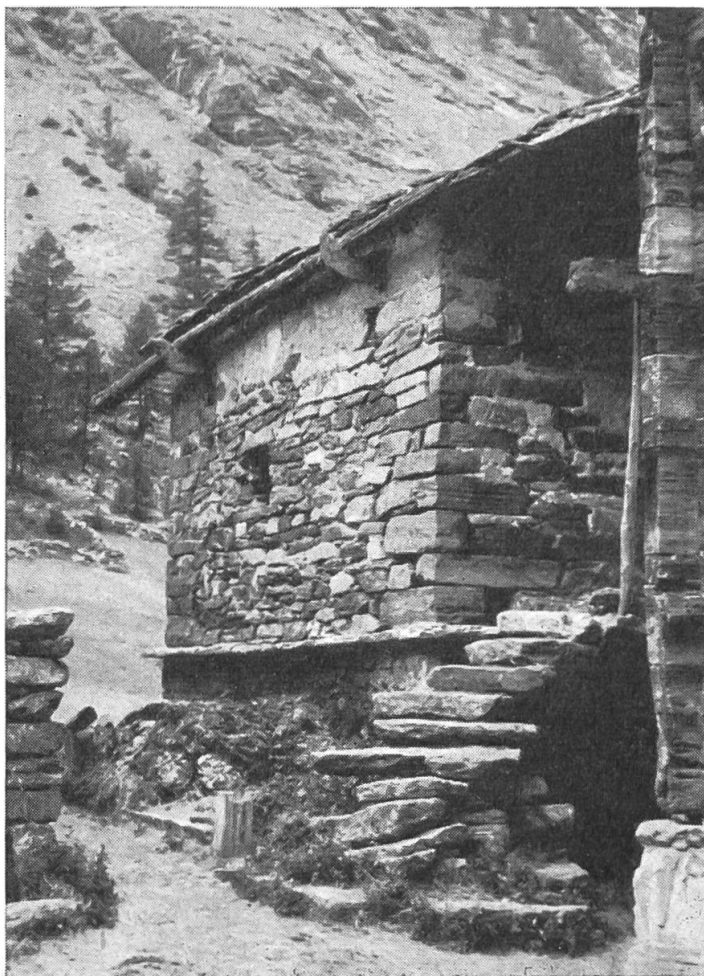
Abb. 2. Zermeiggern: Das sog. Salzhaus.
