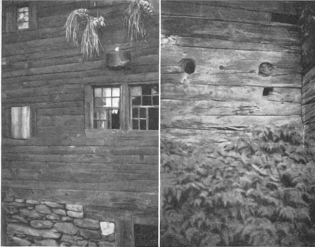
Abb. 11 (links). Stalldenried, Kleeboden. Seelenfenster verbalkt durch helles Brett. Abb. 12 (rechts). Zum Vergleich: Fuchs-Passlöcher, an einem Stall, ziemlich weit unten; mit Hohlbohrern ausgestemmt.
